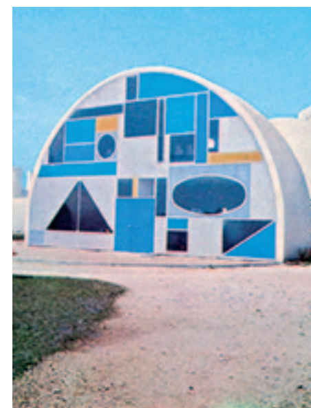
Vera, vitraux pour le village de vacances de Beg-Meil, association Le Renouveau, Henri Mouette architecte, 1965.
